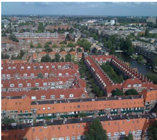
Figuur 2.2. Vooroorlogs bouwblok (bron: Peter de Bois).
