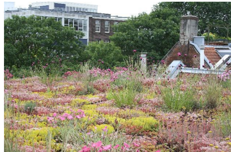
Figuur 2.4. Groendak aan de Keizersgracht in Amsterdam (bron: Rainproof.nl).
