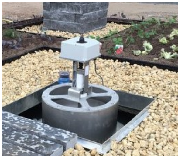
Figuur 3 De Smart Flow Control (foto Optigroen)
