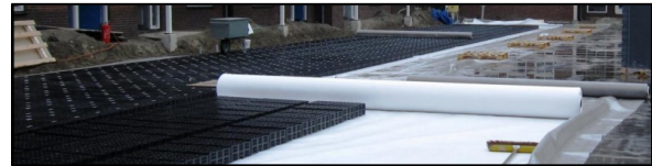
Figuur 6 Permavoid (foto Aquaflow)
