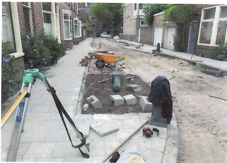
Grondwerk ten behoeve van put Prins Hendikstraat, grondtransport op de vierkante meter, weinig werkruimte.
